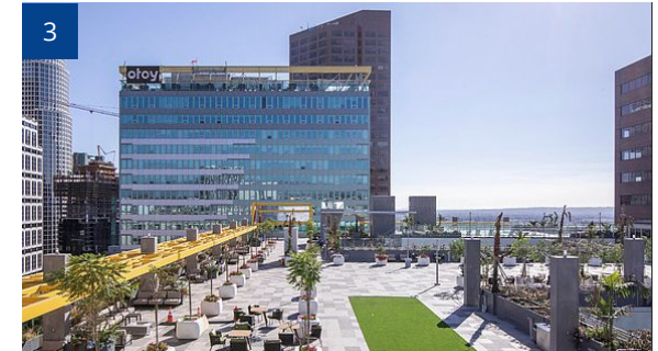
1027 Wilshire Boulevard, Los Angeles, CA
